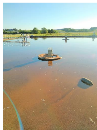
Station d'épuration Crédit : STEP du Bassin de Malemont
